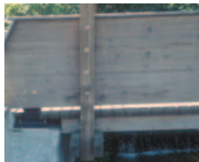
Bild 3 Brücke 1; sachgerechte Ausführung des Auflagers
