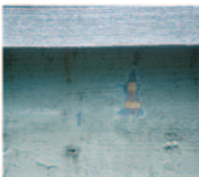
Bild 4 Anstrich auf Außenträger, Probenahme zur Schichtdickenmessung und Fugenbeurteilung
