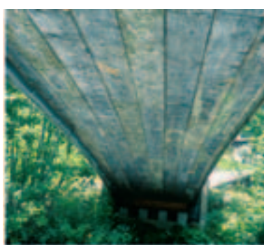
Bild 5 Ansicht von unten, sichtbar ist der partielle Bewuchs des BSH.
